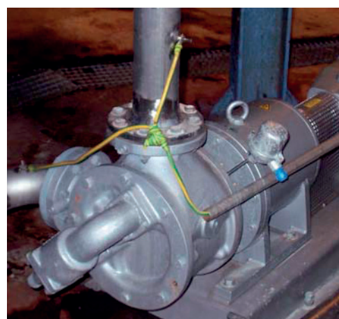
V100-2 STGTRM+Y Liquido trasportato: resina fenolica Pumped fluid: phenolic resin Líquido transportado: resina fenólica
